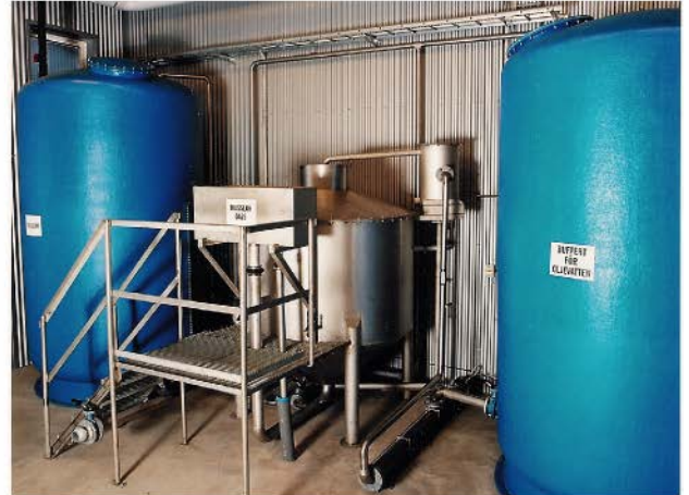
Separación de aceites y solventes etc., para barcos e industrias. Separador de Aceites OA 20. Kapacitet 6 m 3 /timma.
