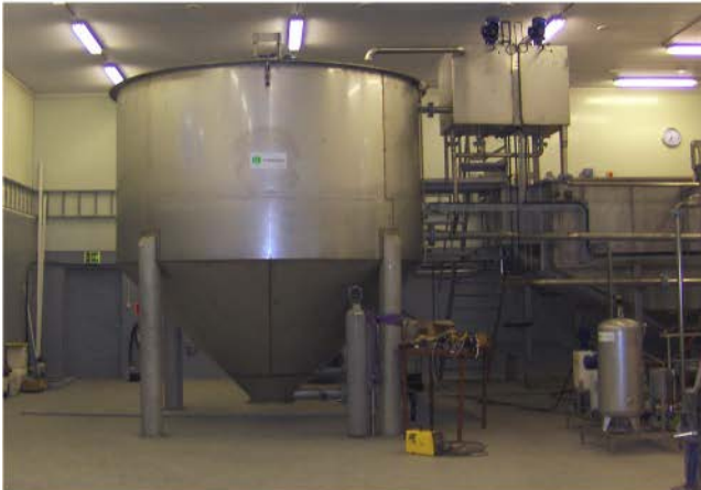
Separador SA 120 en una estación receptora en el Mar del Norte. El separador se ha completado con una etapa de precipitación química
