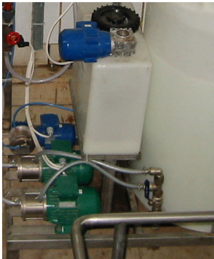
Doseringspumpar på polymerstation SBL 320.
